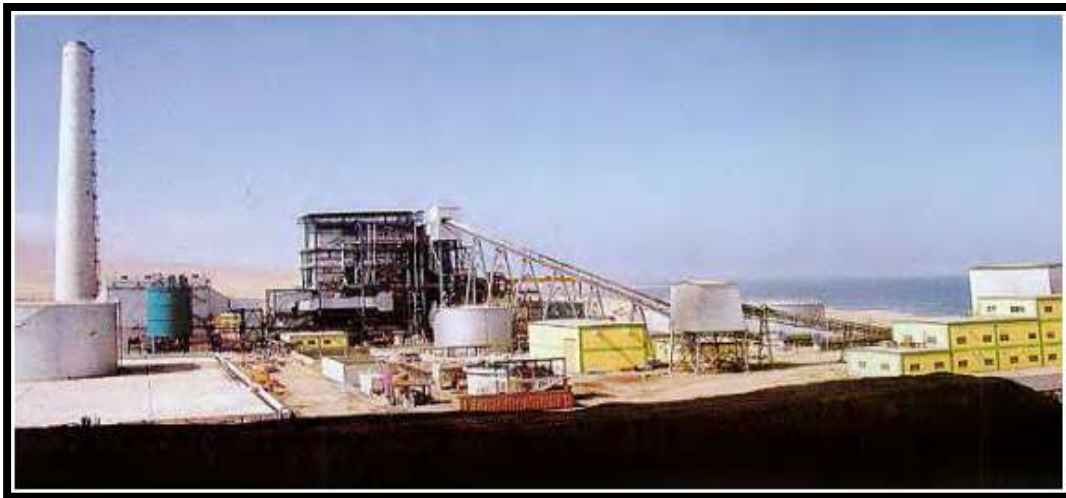
Figura 5: Vista general de la Central Termoeléctrica Ilo21
