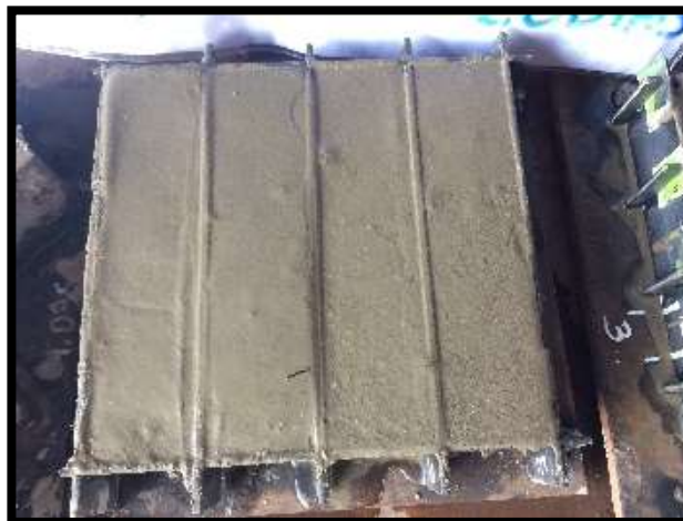
Figura 46: Llenado de los prismas de mortero
