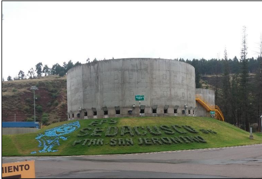
FIGURA N°03: FILTRO PERCOLADOR SECUNDARIO 1 DE LA PLANTA DE TRATAMIENTO DE AGUAS RESIDUALES, SAN JERÓNIMO - CUSCO
