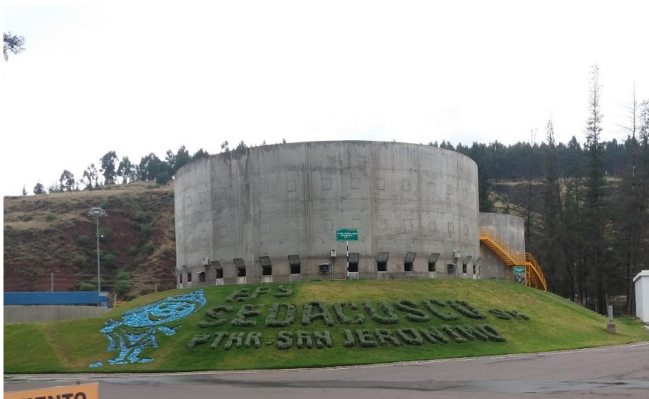
FILTROS PERCOLADORES SECUNDARIOS DE LA PTAR SAN JERÓNIMO - CUSCO
