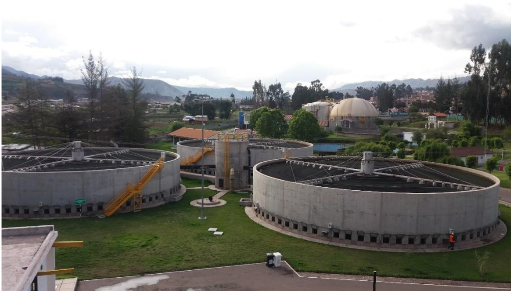
FILTROS PERCOLADORES PRIMARIOS DE LA PTAR SAN JERÓNIMO - CUSCO
