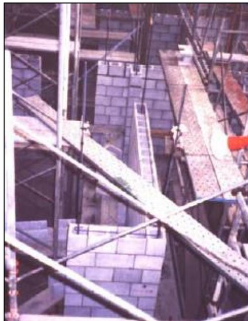
Figura 2 Albañilería armada.
