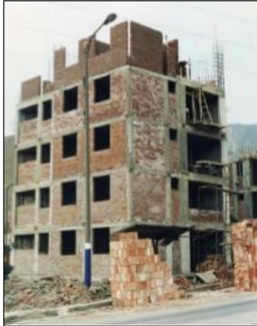
Figura 4 Albañilería confinada.
