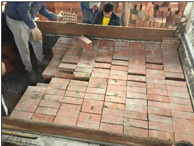
Figura 29 Transporte de ladrillos con puzolana.
