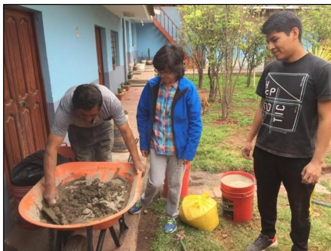
Figura 57 Verificación de dosificación de cemento – agregado.
