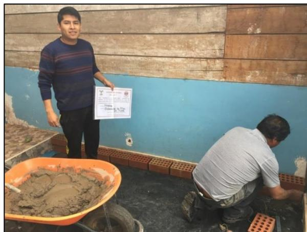
Figura 63 Verificación de dosificación de agregado y agua en pilas desfasadas.
