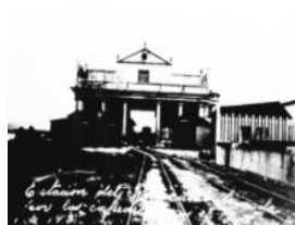
Estación de Gibara demolida
