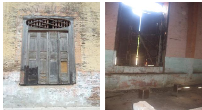
Fig. 14 Estado actual de la carpintería original Fuente: Fotos tomada por la autora, mayo 2018
