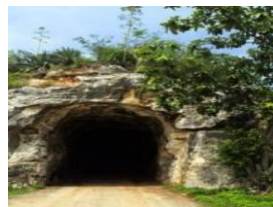
Túnel hecho a mano en Gibara
