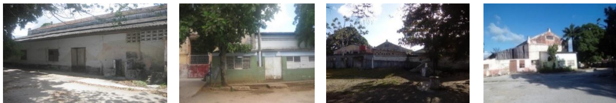
Fig. 4 Imágenes exteriores del inmueble que muestran objetos añadidos Fuente: Fotos tomadas por la autora, enero 2020
