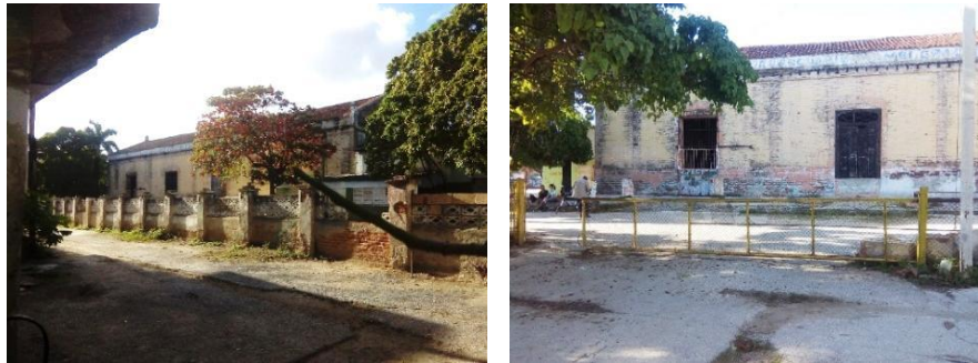
Fig. 2 Imágenes actuales de la edificación Fuente: Fotos tomadas por la autora, enero 2020
