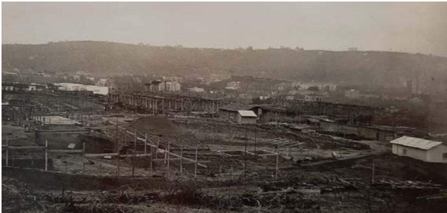
5. Il rione Miraglia dal cantiere della Mostra, 1938. ASNa, Prefettura di Napoli, II Versamento, b. 897.
