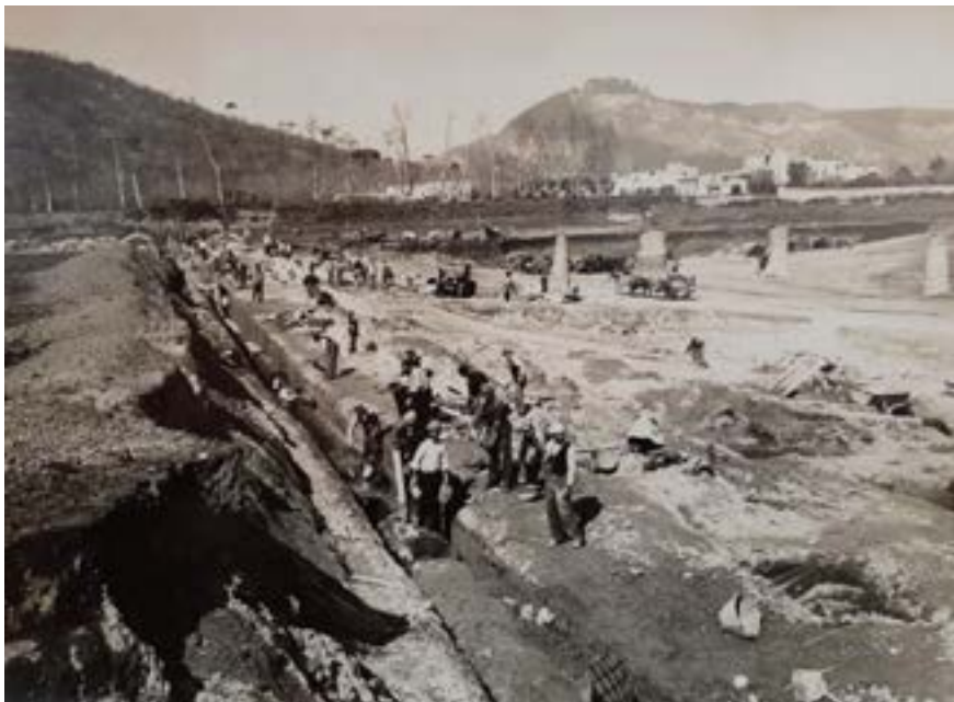
8. Fuorigrotta dal cantiere della Mostra, 1938. ASNa, Prefettura di Napoli, II versamento, b. 897.
