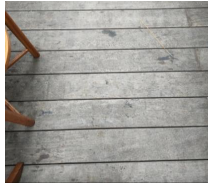
Gambar 19. Material di Lantai 2 Sumber: Survei lapangan, 2020.
