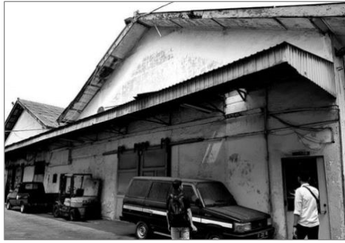
Gambar 2. Kondisi Luar Gudang Sumber: M Bloc Space, 2020.
