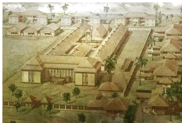
Gambar 1. Kondisi Awal Bangunan Gudang Peruri Sumber: M Bloc Space, 2020.
