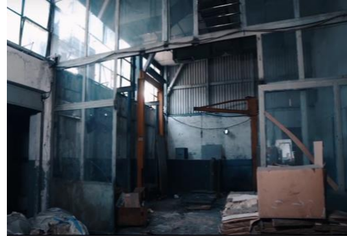
Gambar 3. Kondisi Dalam Gudang Sumber: M Bloc Space, 2020.
