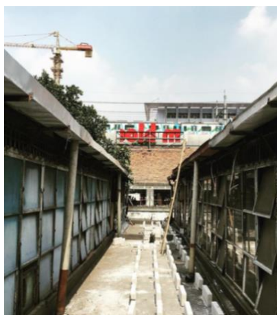
Gambar 8. Proses Renovasi Lantai 2 Sumber: Survei lapangan, 2020.
