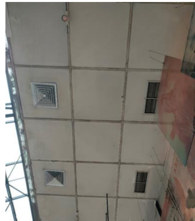
Gambar 21. Plafon Sesuai Aslinya Sumber: Survei lapangan, 2020.
