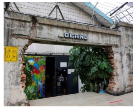
Gambar 5. Dinding yang Dibiarkan Asli Sumber: Survei lapangan, 2020.
