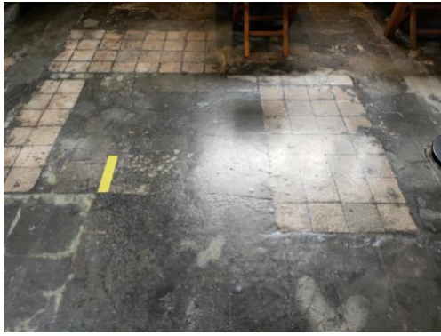
Gambar 18. Material di Lantai 1 Sumber: Survei lapangan, 2020..
