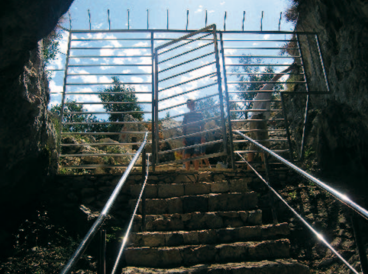
Nova rešetkasta vrata na ulazu
