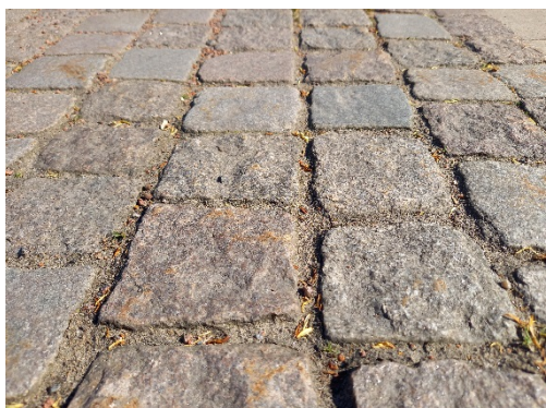
Figur 10. Naturstensyta som har sämre tillgänglighet då ytan är ojämn och fogarna är sämre gjorda.
