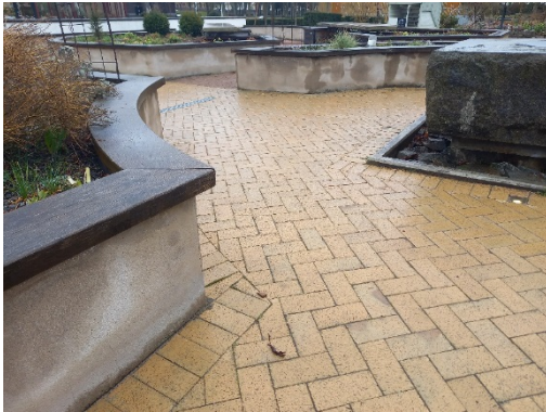
Figur 14. Upphöjda bäddar i betong med sittyta i trä. Markmaterialet består av marktegel.
