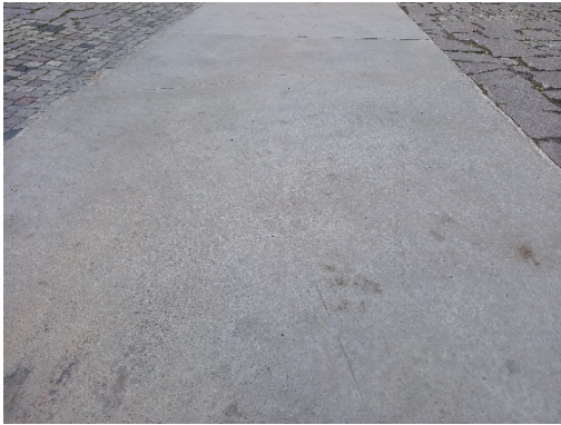
Figur 6. Gångstråk med platsgjuten betong.
