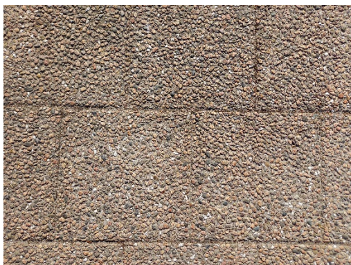
Figur 18. Ett exempel på betongsten med småsten i liknande det material som använd i sinnenas trädgård.
