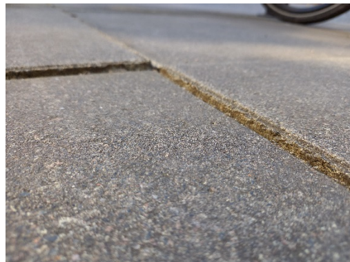
Figur 2. Ett markmaterial där en platta hamnat djupare vilket ger upphov till en ojämn kant.
