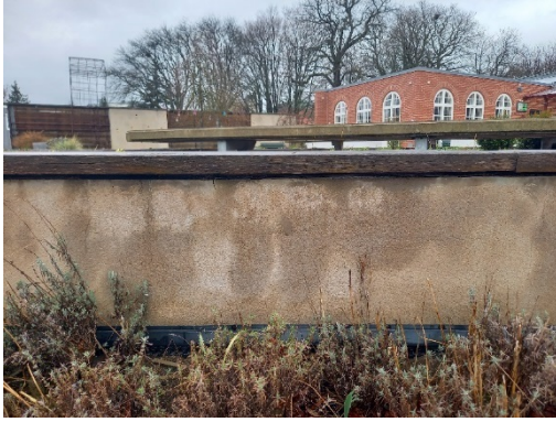
Figur 12. Upphöjd odlingsbädd i betong med en bänk i trä som överliggare.
