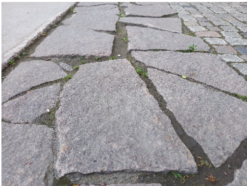
Figur 1. Ett markmaterial med olämplig utformning i offentlig miljö med breda och ojämna fogar.
