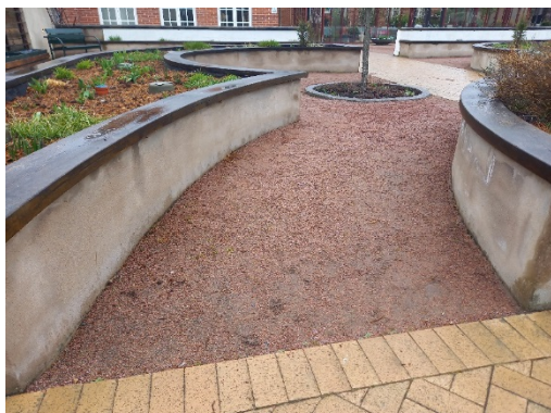
Figur 17. Mötet av olika markmaterial. Marktegel möter stenmjöl.
