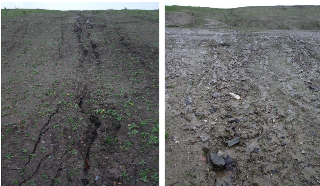
Figur 2 & 3: Foton av Felix Dahlbäck (2020). Bilderna visar hur rännilserosion har bildats på exponerad jord på en anlagd trafikvall intill E6:an vid Åkarp.
