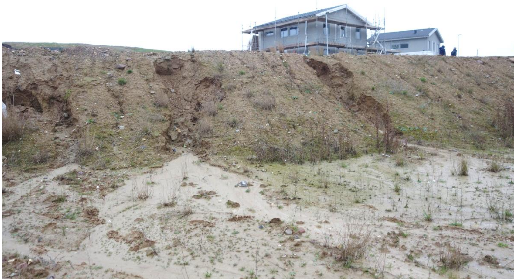
Figur 4: Mindre ravinerosion. Foto av Felix Dahlbäck (2020). Påbörjad ravinerosion i en slänt i samband med nybyggnation av ett villa område i Bara. Även om slänten inte är så lång så har mycket finmaterial kunnat transporteras och ansamlats nedanför.
