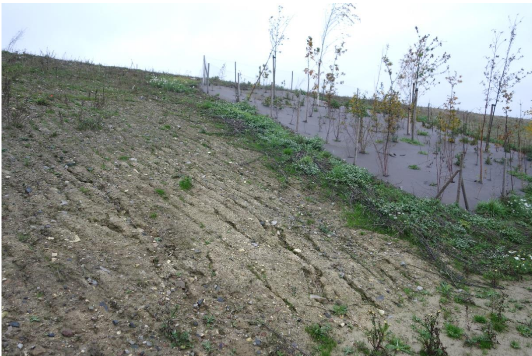
Figur 5: Foto Felix Dahlbäck (2020). Bilden visar ytterligare rännilserosion vid trafikvallen i Åkarp. En tydlig skillnad mellan den bara jorden som är högst eroderande i jämförelse med de etablerade växterna vid planteringen. Viktigt att påpeka att markduken inne i planteringen förmodligen har en stor roll i skyddet mot regndroppar, samtidigt i kanterna av planteringen, visar växterna tydligt dess betydelse för erosionen i jämförelse med den bara jorden.
