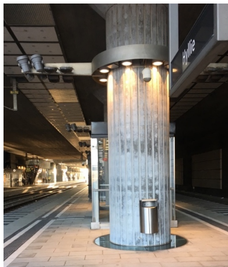
Figur 13. Pelarkonstruktionen på plattformen
