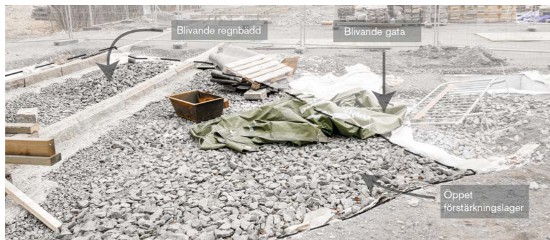
Figur 26. I Rosendal, Uppsala, har det öppna förstärkningslagret breddats från regnbädden ut i gatan för att skapa högre magasinkapacitet.
