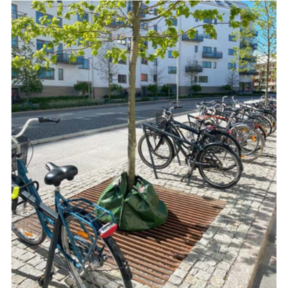
Figur 50. Markgaller i cortenstål matchar sandfångskaren och mellan träden i hårdgjord yta är cykelställ placerade.
