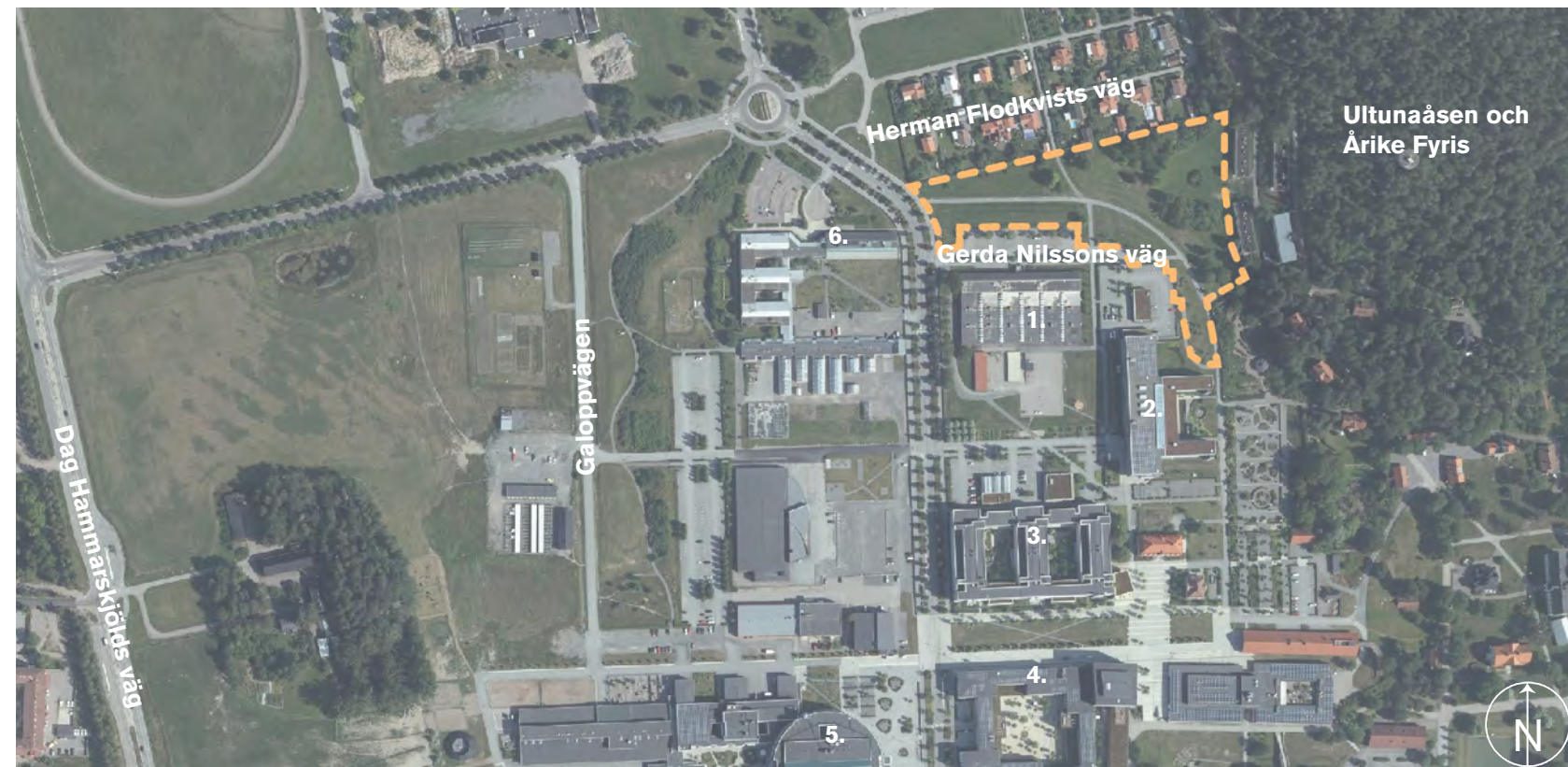
Figur 6. Fallstudiområdet (orange linje) i förhållande till omgivande campusbyggnader (1) Markvetenskapshuset, (2) Mark-Vatten-Miljöcentrum, (3) Biocentrum, (4) Ulls hus, (5) Veterinär- och husdjursvetenskapligt centrum och (6) Ekologikum. Bakgrundskarta: Flygbild skala 1:50 000 © Lantmäteriet, bearbetad av författaren.
