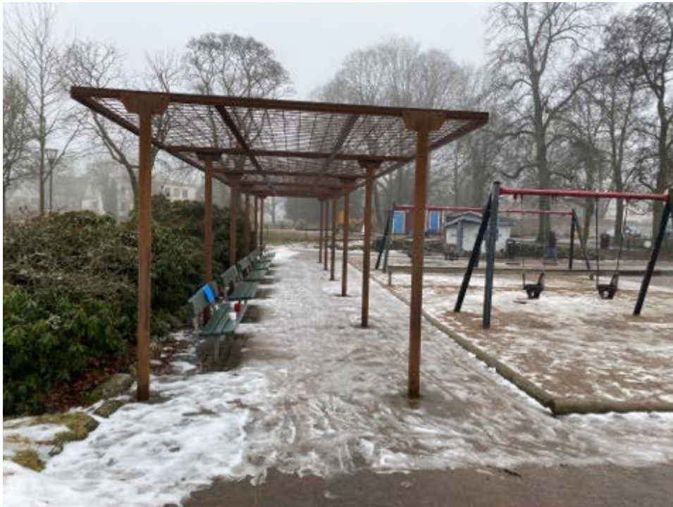
Figur 17 Bänkarna under pergolan i lekplatsen i område 6 är placerade på rad och riktade mot lekplatsen vilket å ena sidan ger en bra uppsikt över barnen men å andra sidan inte bjuder till samtal med andra föräldrar. Foto: Frida Westberg Ekerljung 2021-02-22
