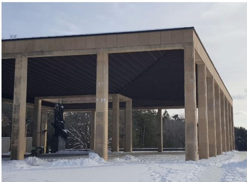
Figur 34. Det Heliga Korsets kapells portiks arkitektur och dess estetik ses som ett svagare visuellt kommunikativt element eftersom det kräver en bakomliggande kulturell förståelse för att kunna tolka och härleda formen till i detta fall klassisk arkitektur (Johansson 1996:99). Det är av denna anledning inte säkert att majoriteten av människorna lyckas förstå symboliken. (Foto av Sandra Andersson 2021-02-18).
