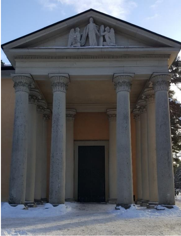
Figur 36. Uppståndelsekapellet. Uppståndelsekapellet med en fris av Ivar Johansson kallad Kristi Uppståndelse samt portik och kolonner i klassicistisk stil (Johansson 1996). Uppståndelsekapellets arkitektoniska estetik ses som ett svagare visuellt kommunikativt element eftersom det kräver en bakomliggande kulturell förståelse för att kunna tolka det den arkitektoniska stilen symboliserar. Det är av denna anledning inte säkert att det går att tolka av majoriteten av människorna. (Foto av Sandra Andersson 2021-02-18).
