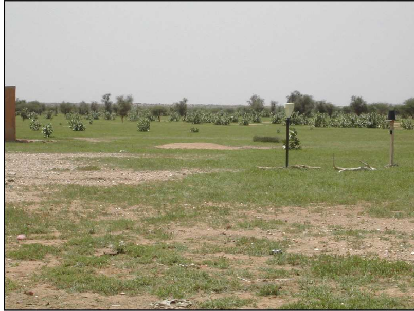
Photo 11 : Station de Zagora avec les deux types de pluviomètres
