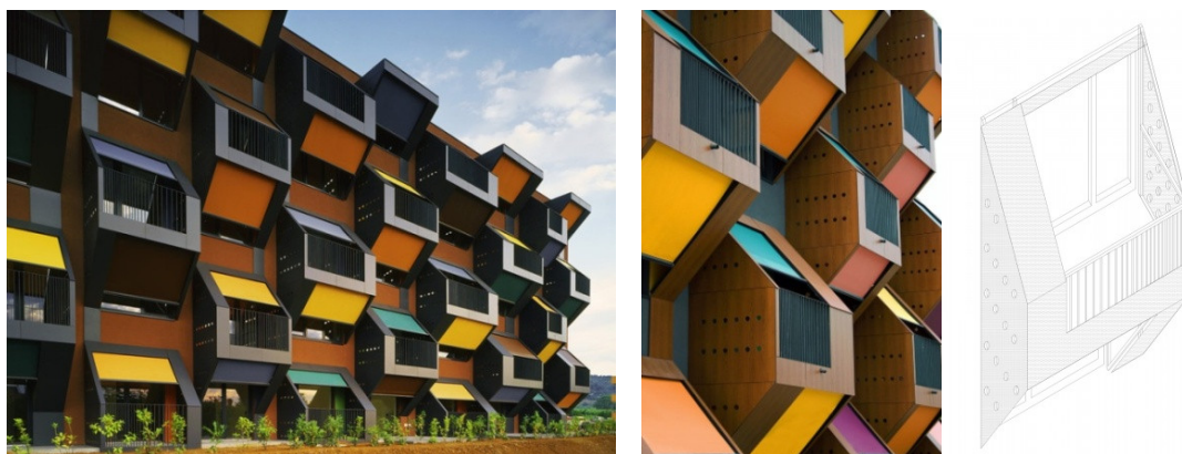
Слика 40. Izola / OFIS arhitekti (2006), Изола, Словенија (Извор: https://www.archdaily.com/3245/izola-social-housing-ofis-arhitekti )
