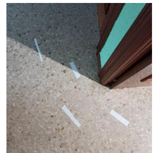
Imagen 22. Líneas de tape en marco de puerta
