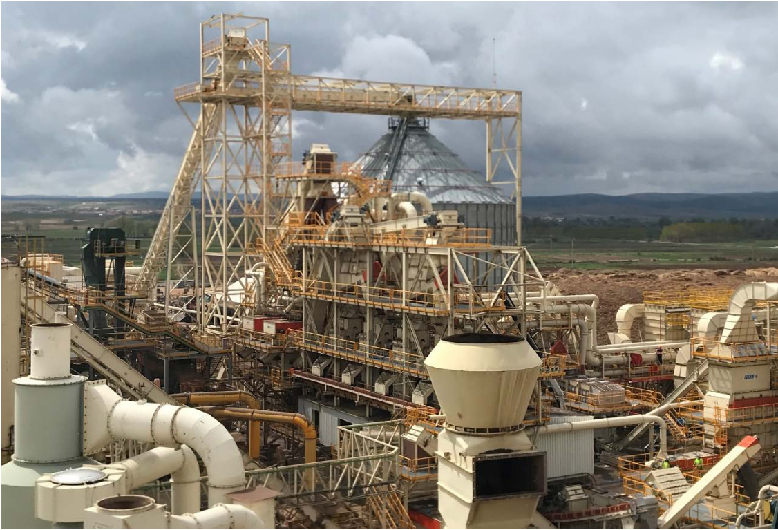
Imagen 16: Montaje de la maquinaria de la línea de limpieza (Vista lateral).
