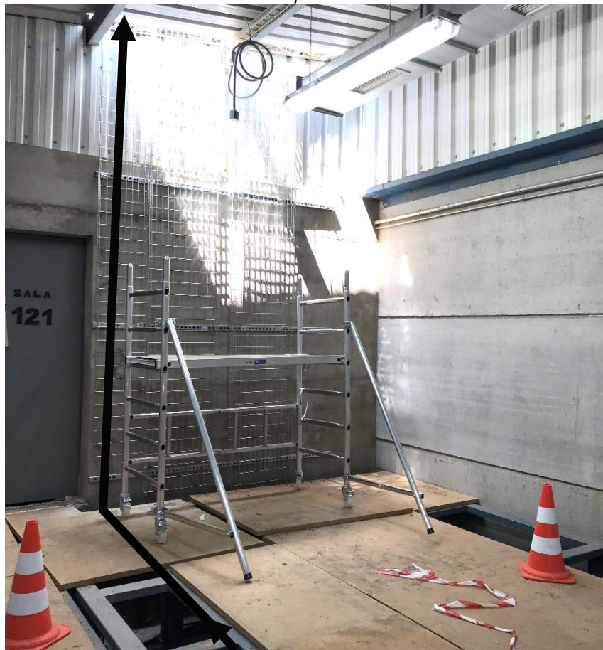
Imagen 11: Salida de los cables al tejado de la sala desde los cuadros eléctricos hasta campo, cosidos en el falso suelo sobre una rejiband
