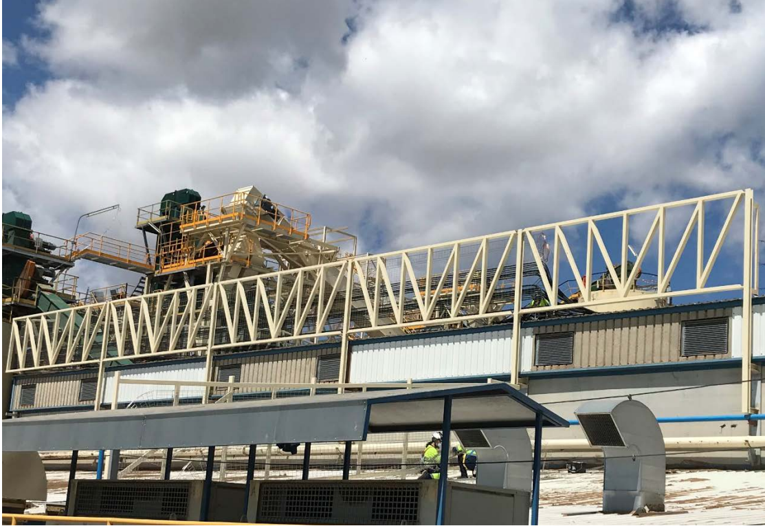
Imagen 12: Celosía sobre la que se coloca la rejiband para un tendido de cables más sencillo hasta campo.
