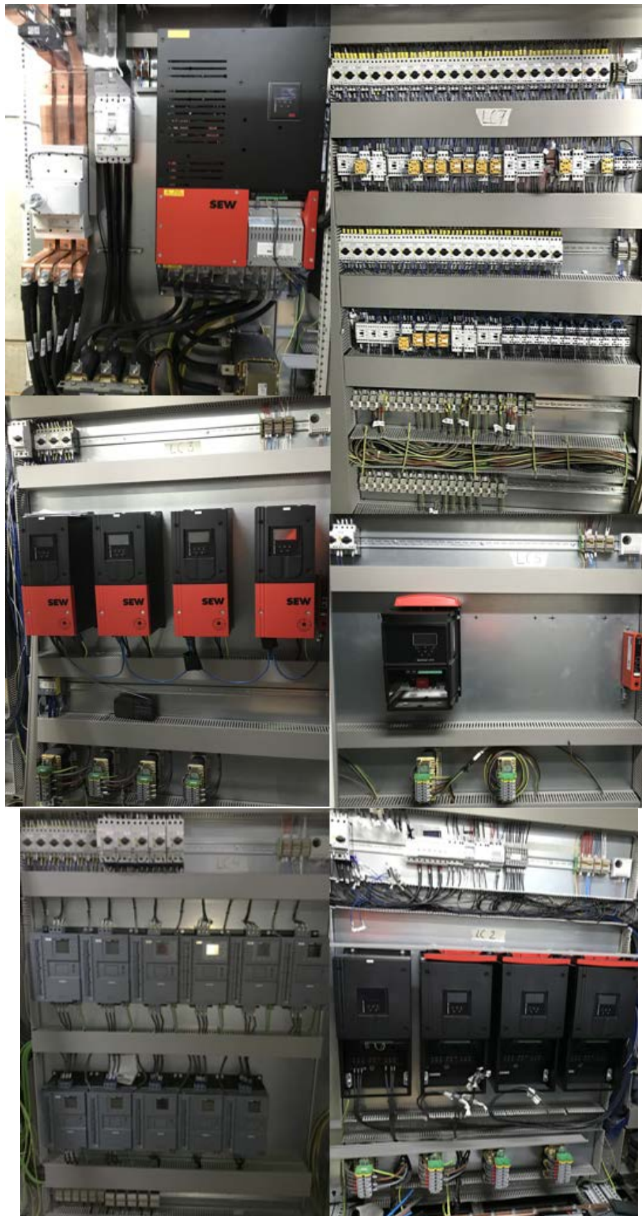
Imagen 13: Montaje de los armarios eléctricos de la Línea Comunes
