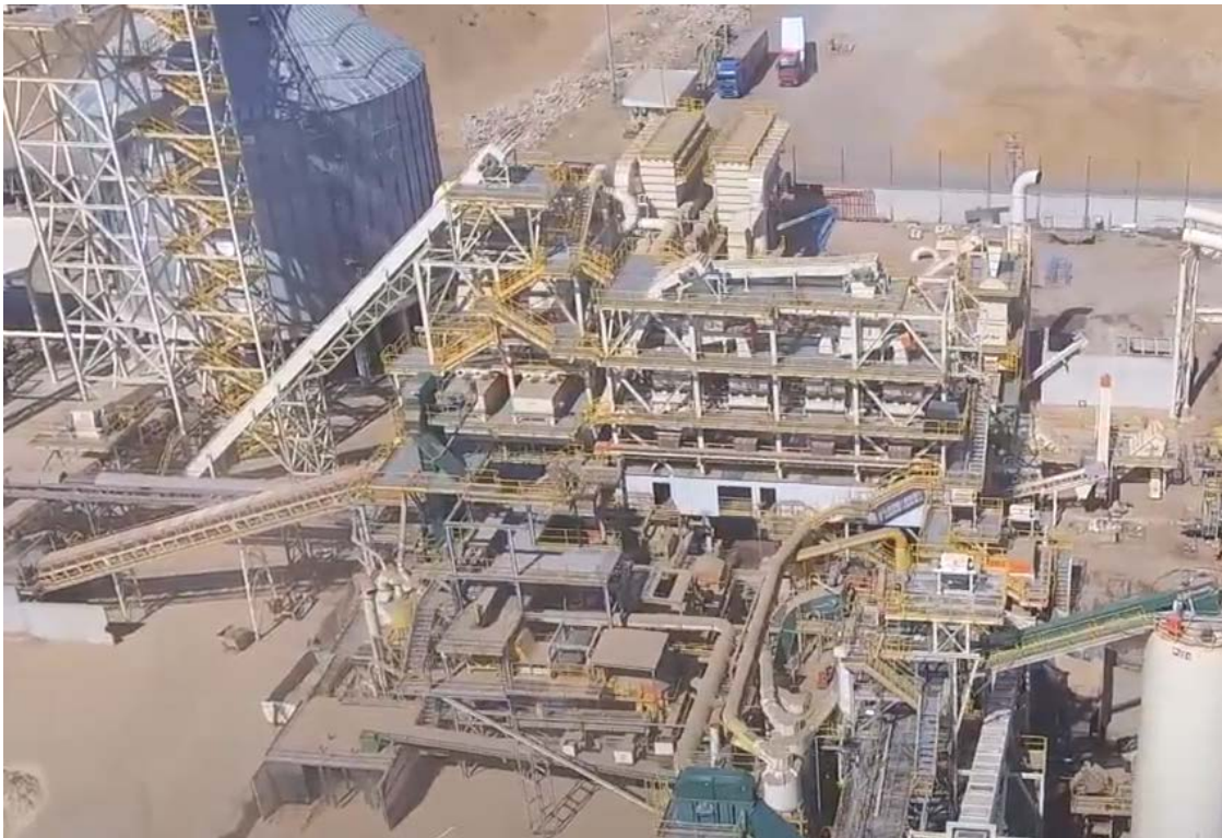
Imagen 17: Montaje de la maquinaria de la línea de limpieza (Vista frontal).
