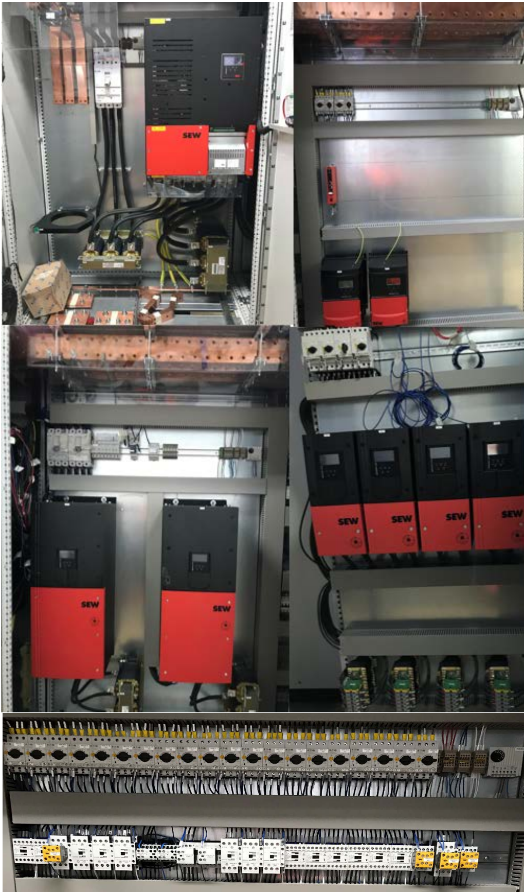
Imagen 15: Montaje de los armarios eléctricos de la Línea 2
