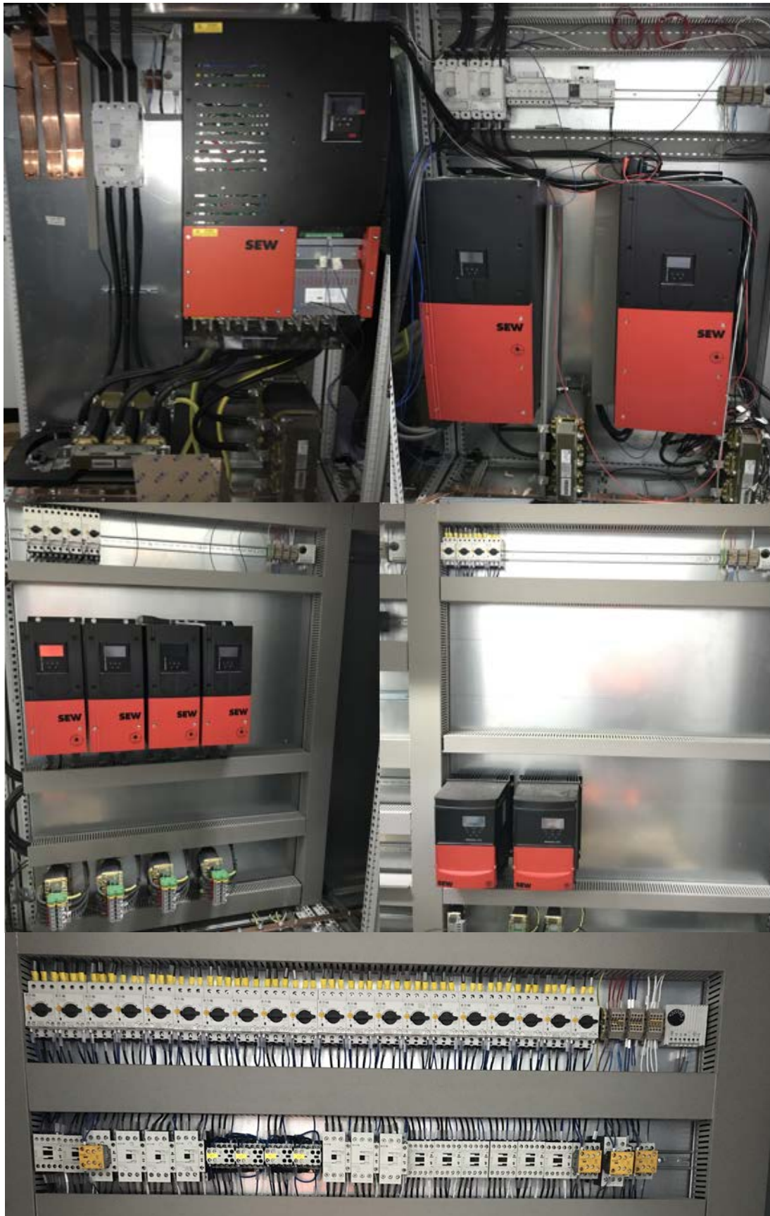
Imagen 14: Montaje de los armarios eléctricos de la Línea 1
