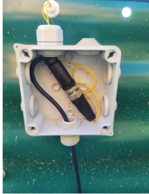
*Figura 62. Conexión del sensor del depósito*
