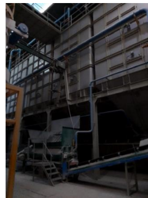
Imagen 3: Silos de almacenamiento.
