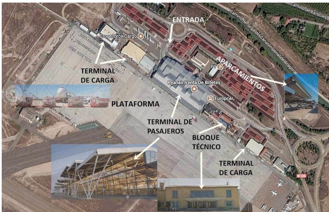
Imagen 1: Zonas del aeropuerto de Zaragoza
