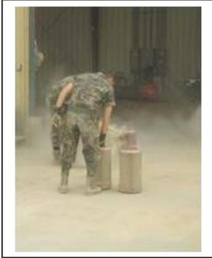
*Ilustración 11. Limpieza de los cartuchos de filtro de papel del sistema de admisión. Fuente: Informe Arabia Saudí.*
