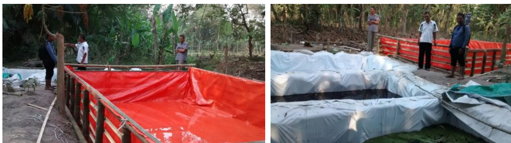
Gambar 10. Perbaikan kolam dengan pelapisan terpal.
