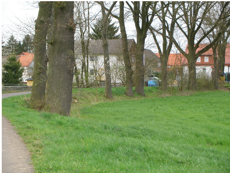
Abb. 21: Aufgeschütteter und mit Bäumen befestigter Weg bei Salmshausen, um die Befahrbarkeit bei Hochwasser sicherzustellen.
