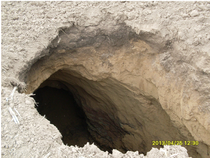
Abb.12 Tagesbruch am Galgenberg bei Alsleben (Foto: G. PFAFF)
