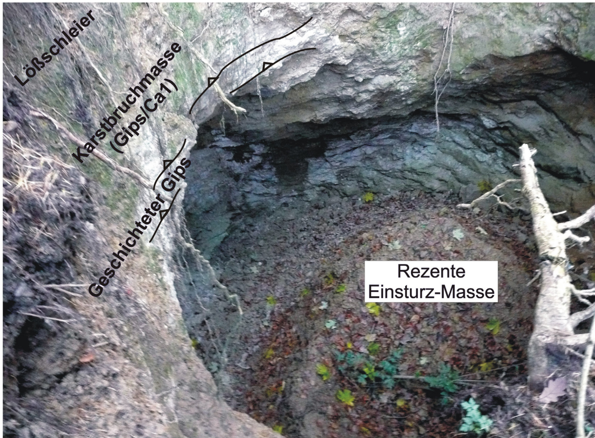
Abb. 2 Blick in den nahezu kreisförmigen östlichen Karsteinbruch mit ca. 3 m im Durchmesser (Koordinaten: R 44 22 608, H 57 44 115; Aufschlussituation am 2. März 2014). Unter einer dünnen Bodendecke und einem Lößschleier folgen 1-2 m mächtige Zechstein-Residuate und darunter steil nach NNE einfallende undeutlich geschichtete Gipse (Werra-Sulfat/A1).
