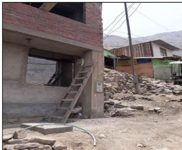
Uso de ladrillo pandereta en el segundo piso, se observa la construcción de una columna para las instalaciones de la caja eléctrica.
