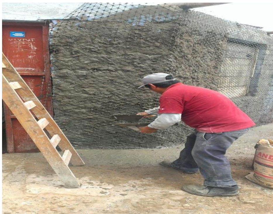
Figura 112. Pañeteo de muros con geomalla.
