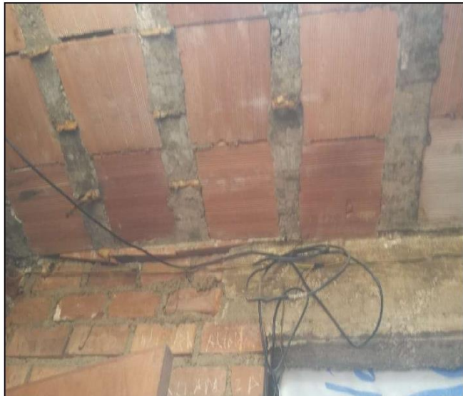
La viga no se apoya sobre una columna, en esta imagen se ve que la viga se apoya sobre el muro.
