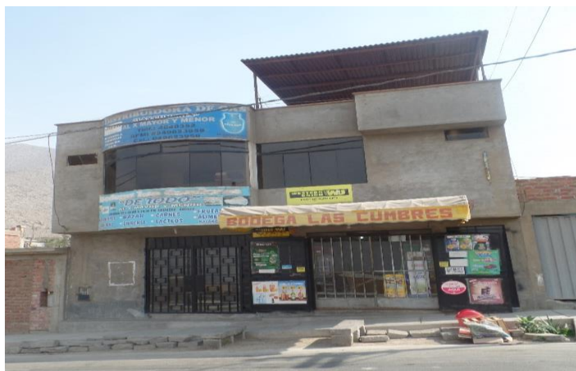
Figura 115. Vivienda sobre un suelo de relleno.
