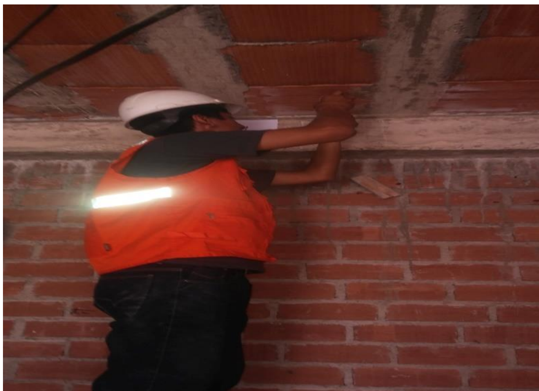
Figura 174. Ensayo de esclerometría a la viga en la vivienda de dos pisos.
