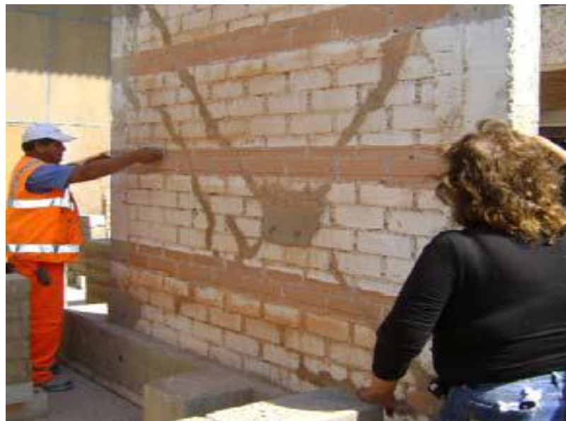
Figura 109. Demarcación de las fibras de carbono.
