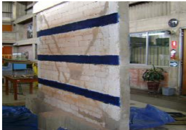
Figura 110.Reparación y reforzamiento de con fibras de carbono.
