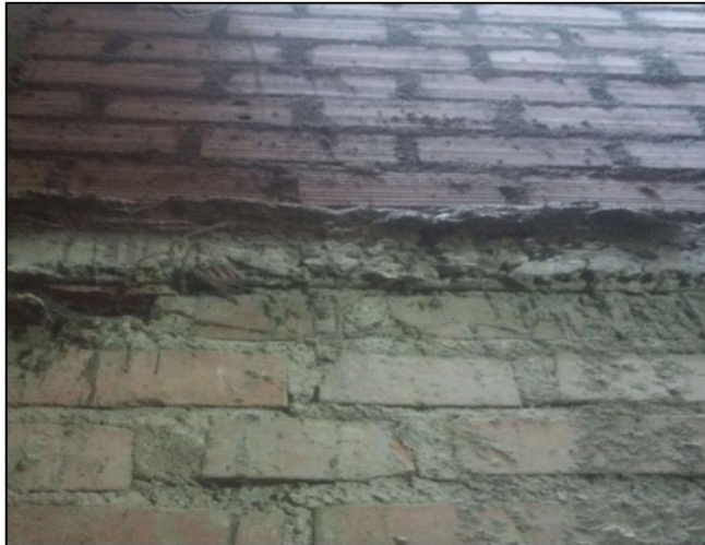
Uso de diferentes ladrillos en la vivienda, en el primer piso ladrillo macizo, mientras que en el segundo piso ladrillo pandereta.
