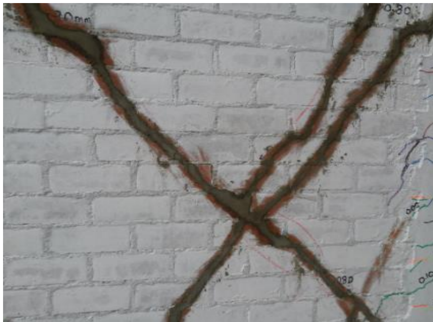
Figura 107. Rellenado de las grietas con la mezcla de mortero.
