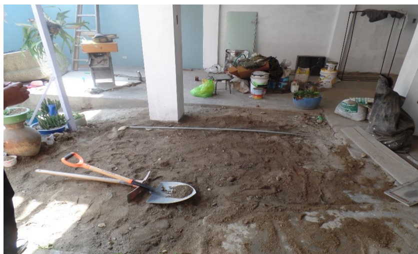
Figura 169. Rellenado de la calicata excavada.
