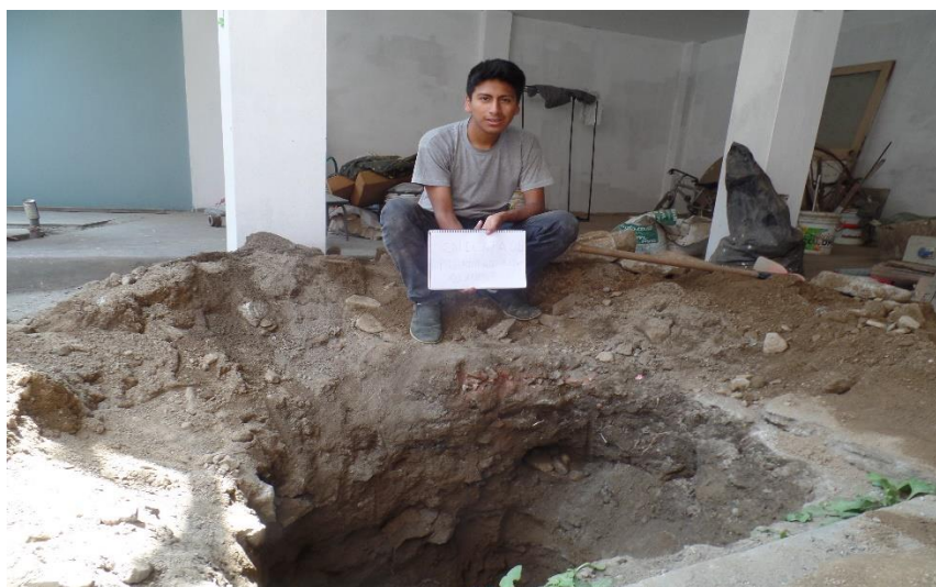
Figura 168. Calicata en el asentamiento Humano Huascata.
