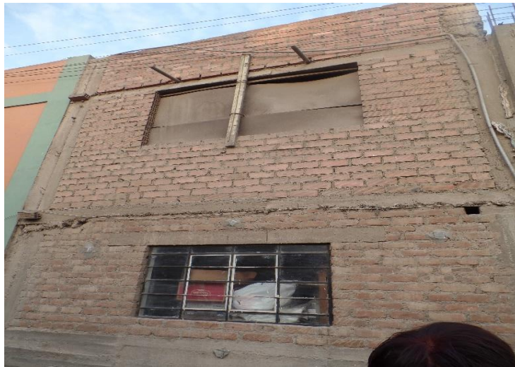
Figura 120. Primera planta ladrillo macizo, segunda planta ladrillo pandereta.
