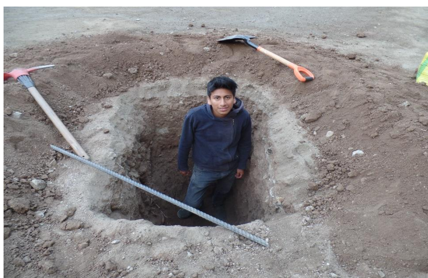
Figura 170. Calicata en el Asentamiento Humano Don Bosco.
