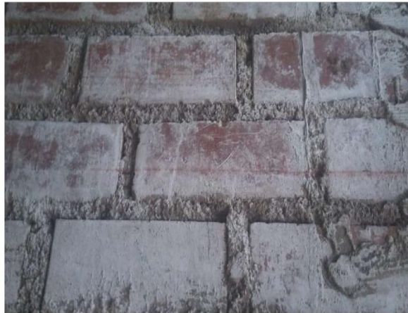
Junta de construcción de la vivienda de 2.5 cm.
