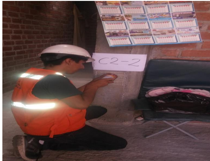
Figura 68. Ensayo de esclerometría a la columna en la vivienda de dos pisos.
