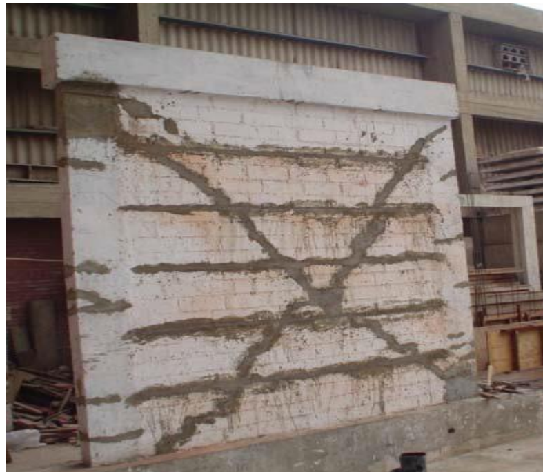
Figura 111.Reparación y reforzamiento de con fibras de vidrio.
