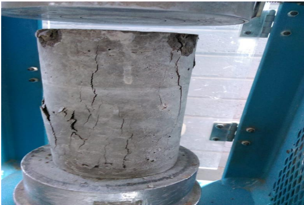
Falla en la ruptura del testigo
