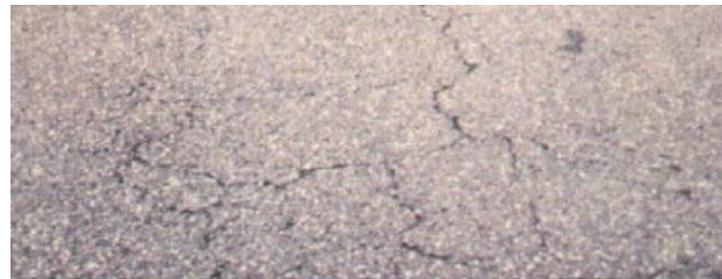
*Figura 10. Nivel de severidad Medio - PC, (Ministerio de Transportes y Comunicaciones, 2018).*
