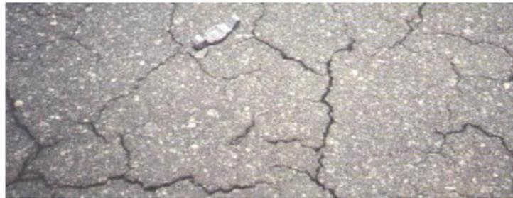
*Figura 9. Nivel de severidad Bajo - PC, (Ministerio de Transportes y Comunicaciones, 2018).*
