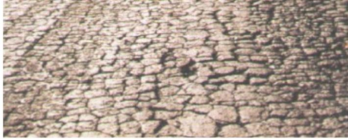
*Figura 11. Nivel de severidad Alto - PC. Fuente: (Ministerio de Transportes y Comunicaciones, 2018).*
