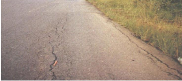
Figura 23. Nivel de severidad Alto - GLT. (Ministerio de Transportes y Comunicaciones, 2018).
