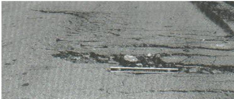
*Figura 26. Nivel de severidad Alto - GPD. Fuente: (Ministerio de Transportes y Comunicaciones, 2018).*
