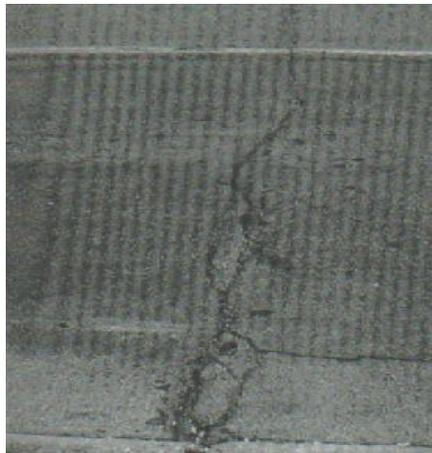
*Figura 19. Nivel de severidad Medio – GRJ. (Vásquez Varela, 2002).*
