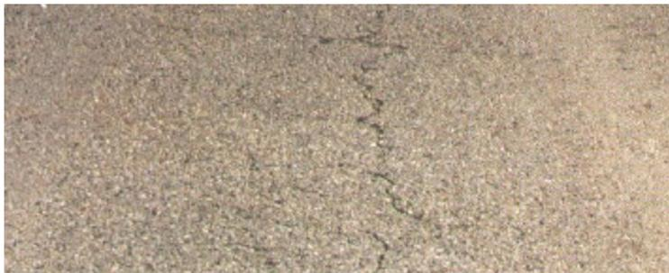
*Figura 22. Nivel de severidad Medio - GLT. (Ministerio de Transportes y Comunicaciones, 2018).*
