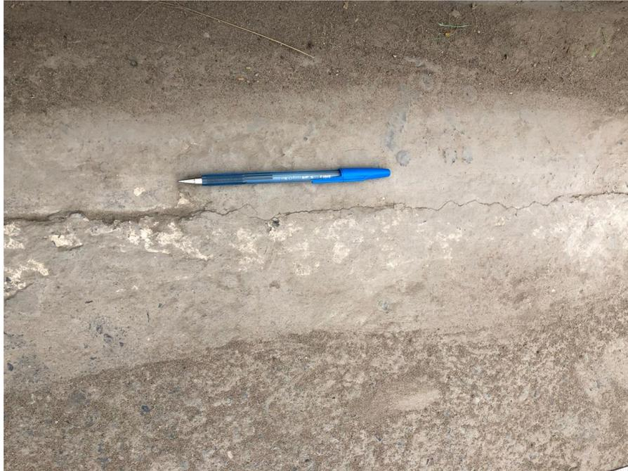
Figura 220. Fisuras de Reflexión de Junta.
