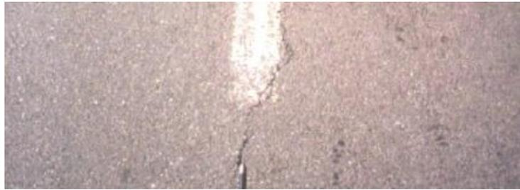
*Figura 21. Nivel de severidad Bajo – GLT. (Ministerio de Transportes y Comunicaciones, 2018).*
