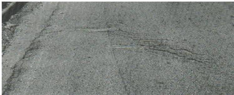
*Figura 25. Nivel de severidad Medio - GPD. (Ministerio de Transportes y Comunicaciones, 2018).*
