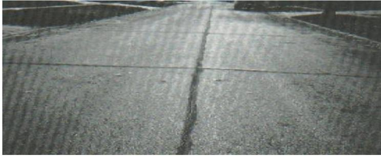
*Figura 18. Nivel de severidad Bajo – GRJ. (Vásquez Varela, 2002).*
