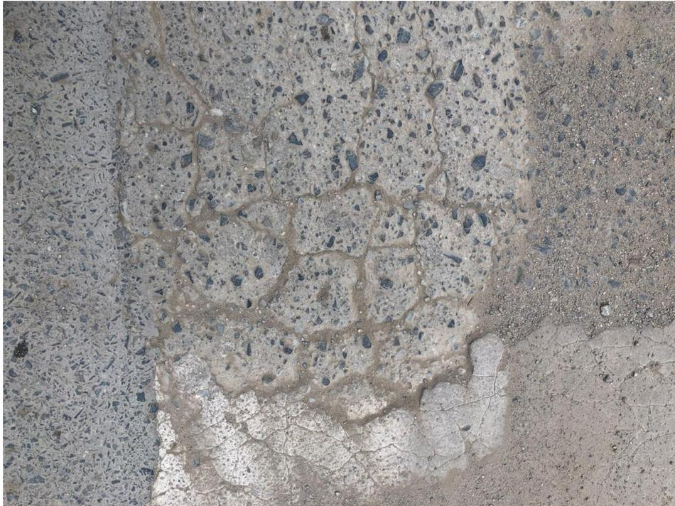
*Figura 226. Fisuras en Bloque.*
