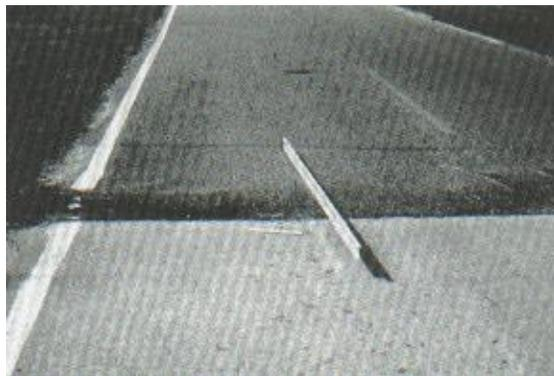
Figura 41. Nivel de severidad Alto - D. Fuente: (Vásquez Varela, 2002).
