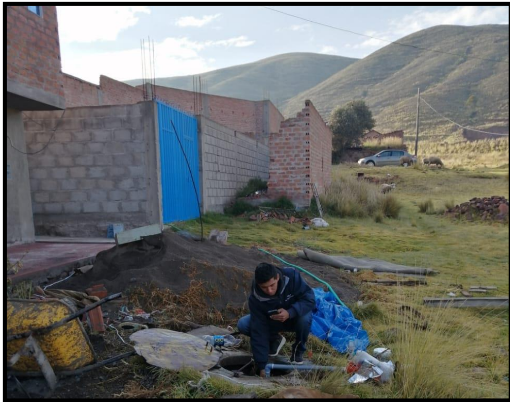
Fotografía 17. Aforo de pozos en el sector.
