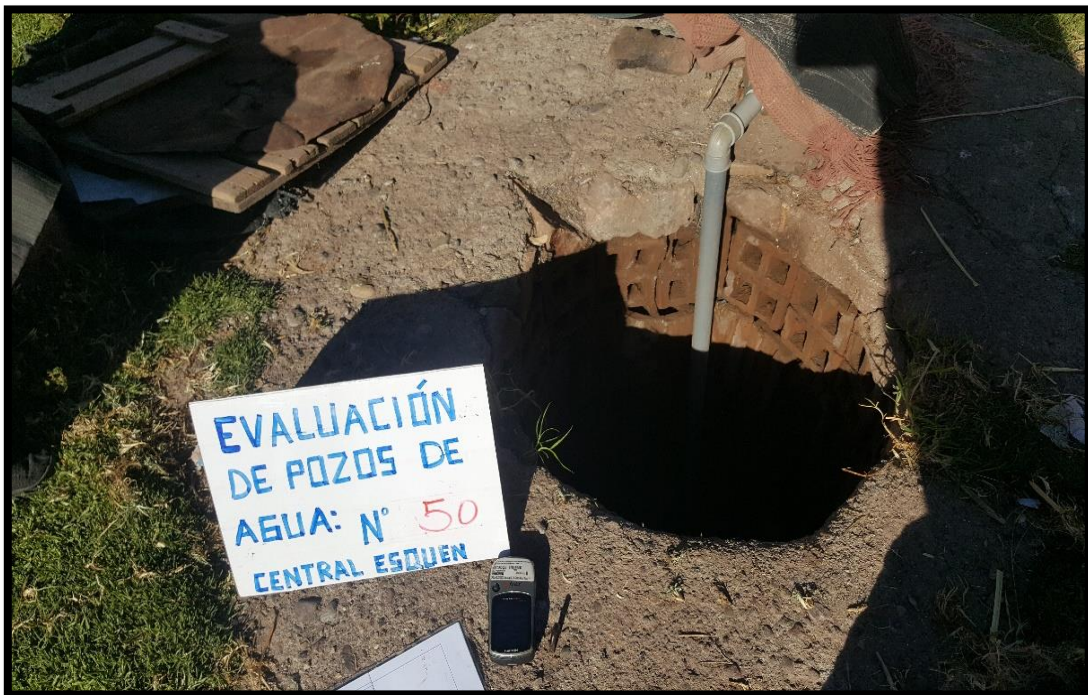
Fotografía 2. Evaluación De Pozo N°50 - Revestimiento De Ladrillo.
