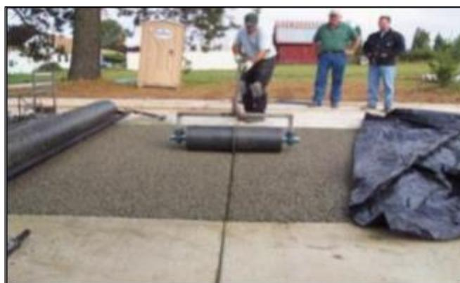
*Figura 17.* Corte de las juntas del pavimento drenante.
