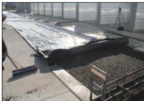
*Figura 19. Material de polietileno usado para cubrir la superficie expuesta del concreto permeable. Adaptado de (Tennis et al., 2004).*
