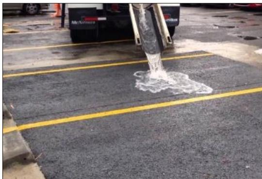
*Figura 4.* Pavimentos de Asfalto Poroso. Adaptado de Youtube.
