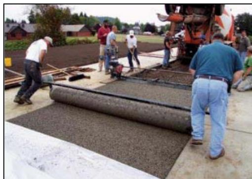
*Figura 16.* Compactación del pavimento drenante. Adaptado de “Pervious concrete pavements” por Tennis Paul D, 2014.
