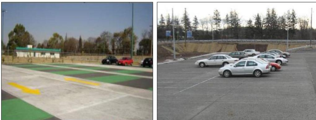
*Figura 11.* Pavimento permeable en asfalto poroso en el estacionamiento de la planta de Schnyder Electric en Tlaxcala, México. Adaptado de Schnyder Electric.
