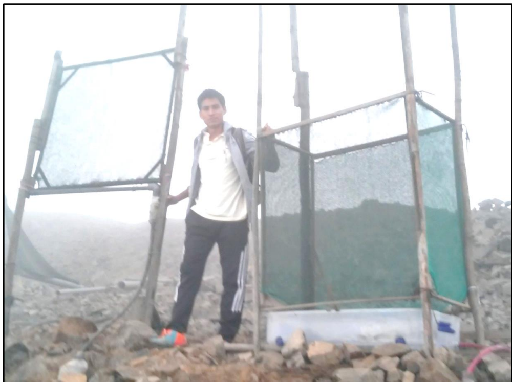
Figura 30. Instalación de los atrapanieblas
