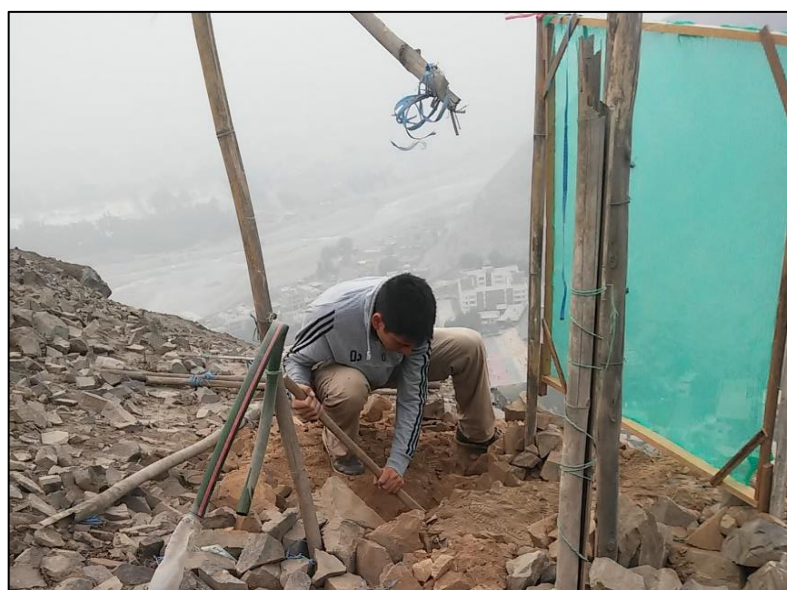
Figura 29. Limpieza de área previa instalación de los atrapanieblas
