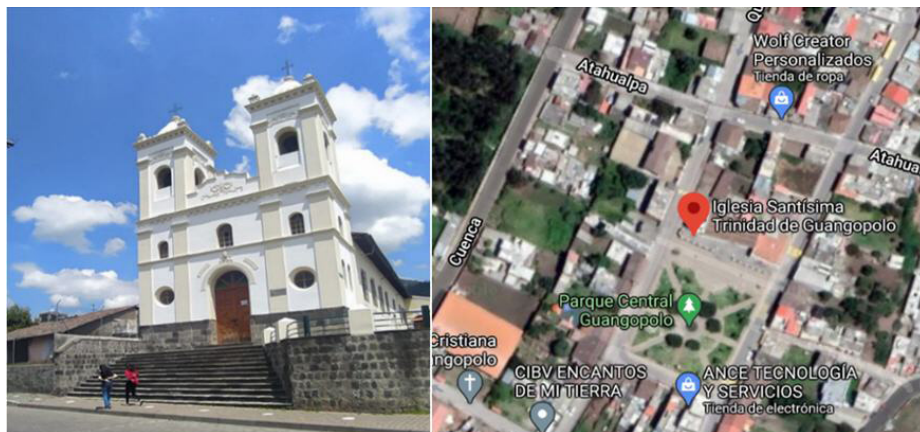
Figura 12. Ubicación y vista de la Iglesia Santísima Trinidad.
