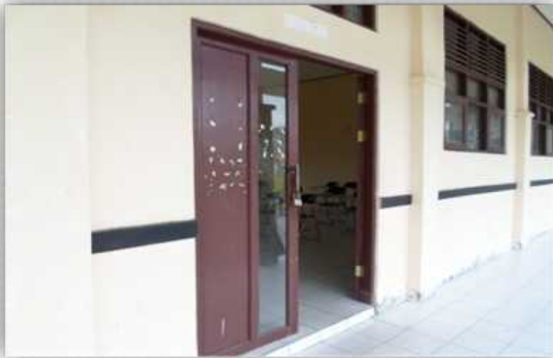
Gambar 2. Pintu ruang kelas yang dapat di buka
