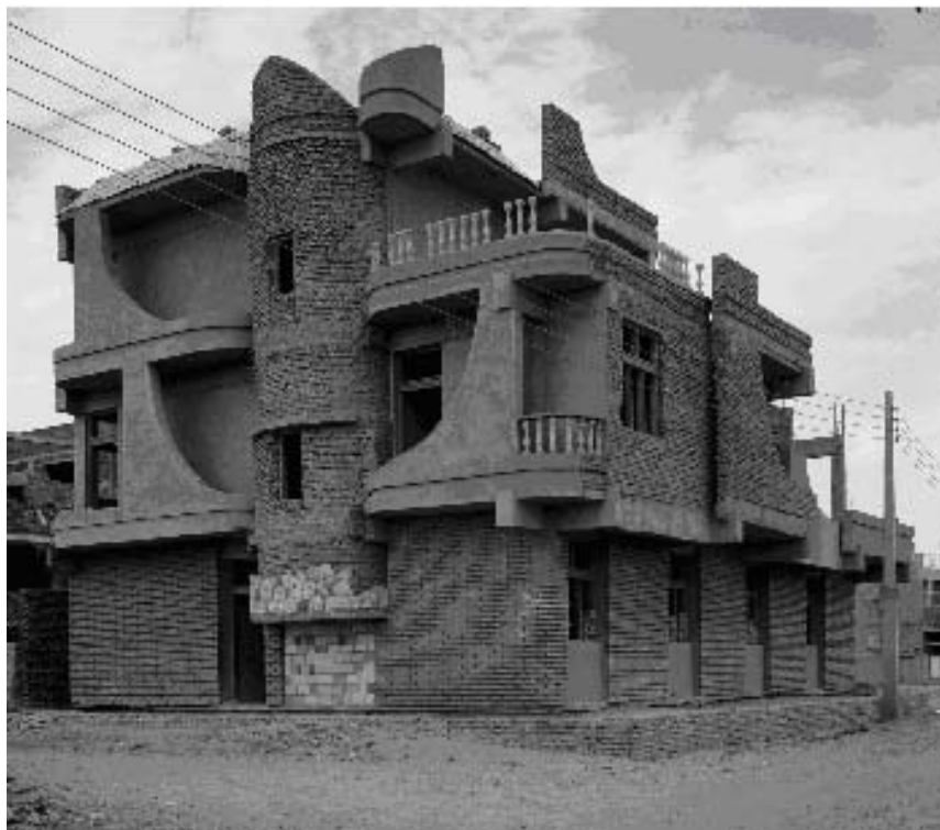
Photo n°4 : Villa en construction - Manshiya – 2001 (C. Iverné)
