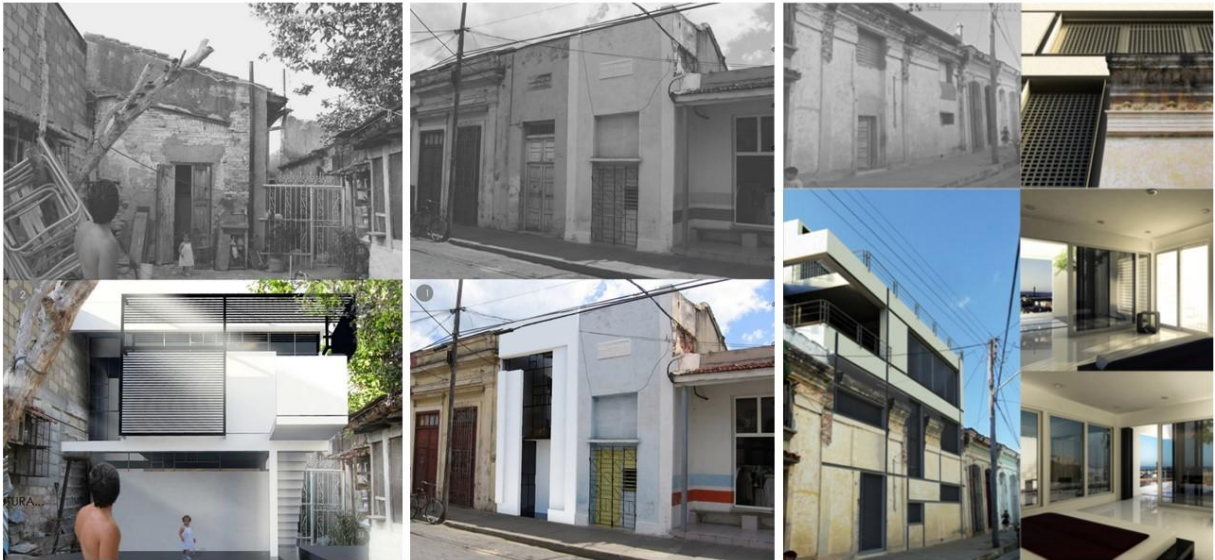
Figura 2: Proyectos realizados por el grupo ALBOR y ejecutados por autoconstrucción en el centro histórico de la ciudad de Cienfuegos, siguiendo el enfoque teórico – metodológico desarrollado.
