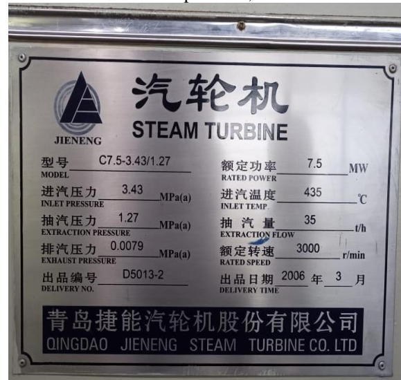
Gambar 4. Spesifikasi teknis turbin uap di PLTU PT. Harjohn Timber
