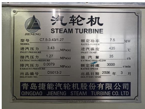
Gambar 4.2. Spesifikasi Teknis Turbin Uap di PLTBm PT. Harjohn Timber.
