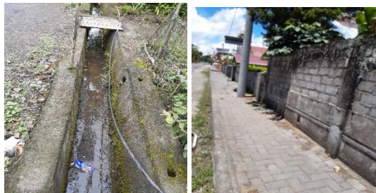
Gambar 4. Peta Jaringan Drainase Tahun 2019 Gambar 5. Kondisi Drainase Tahun 2019
