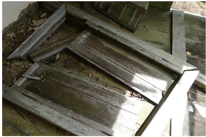
図 2-2-12 六川家住宅の窓枠
