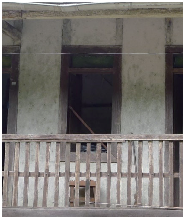
図 2-2-11 北面ベランダに面する窓枠
