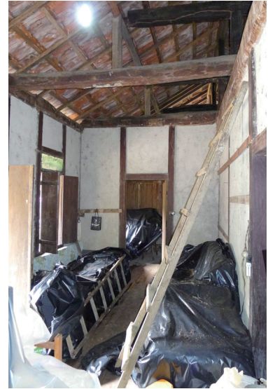
図 2-2-4 リビング内部
