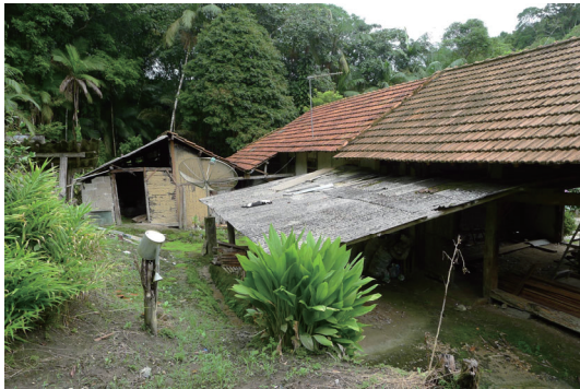
図 2-2-5 南側の下屋と離れ外観
