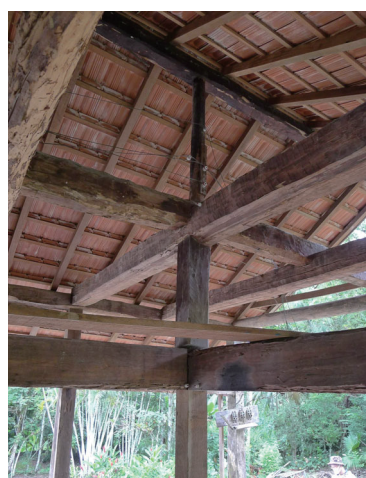
図 2-2-10 納屋の小屋組み
