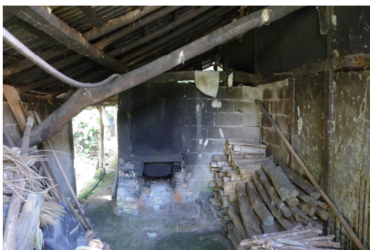
図 2-2-7 浴室裏側の焚口
