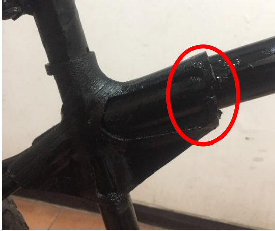
Gambar 4.13 Retakan akibat beban hantakan.
