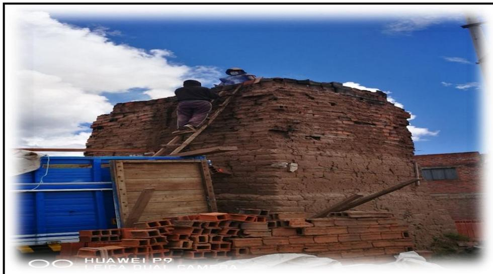
Figura 11 Realizando el horneado de los ladrillos
