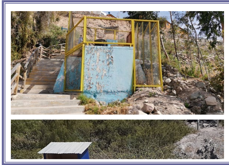
FOTO N° 09: se consideró el reservorio existente el cual está en funcionamiento actualmente con tubería de PVC de 63mm.
