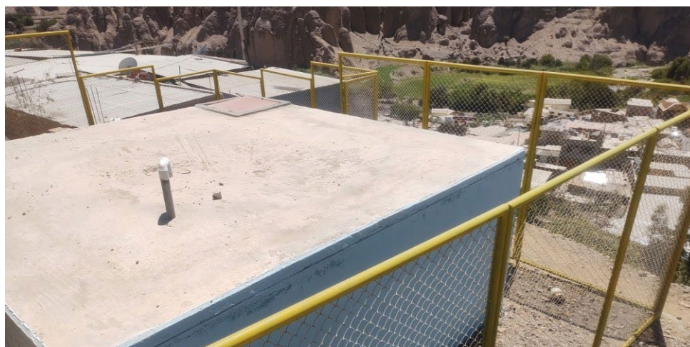
Figura 17.- Reservorio N°2 – Rectangular Tipo Apoyado
