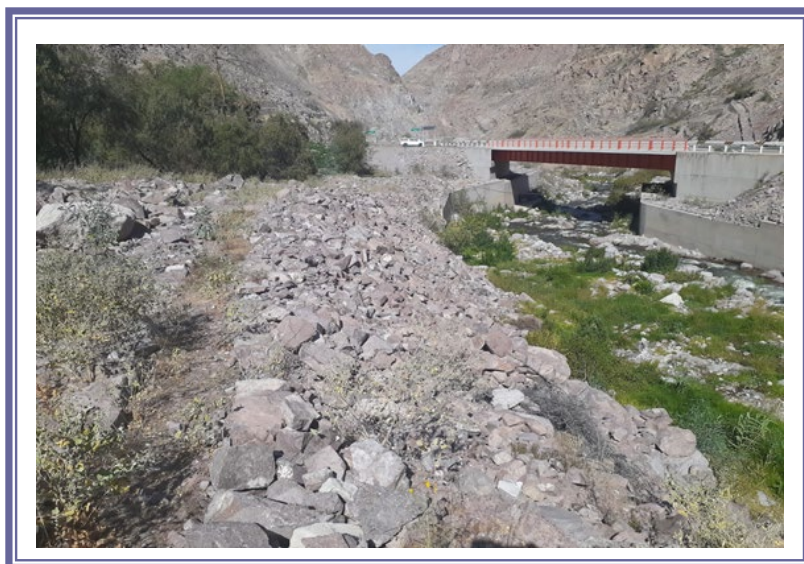
FOTO N° 02: DESARENADOR (Progresiva 0+250, aprox. - Ref.
