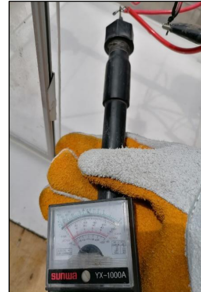
FOTO 51: Medimos con ayuda de la sonda los 15000 voltios que se aplicaran durante el tratamiento con el reactor.
