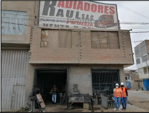
FOTO 1: Fachada de la empresa Radiadores Raúl S.A.C.
