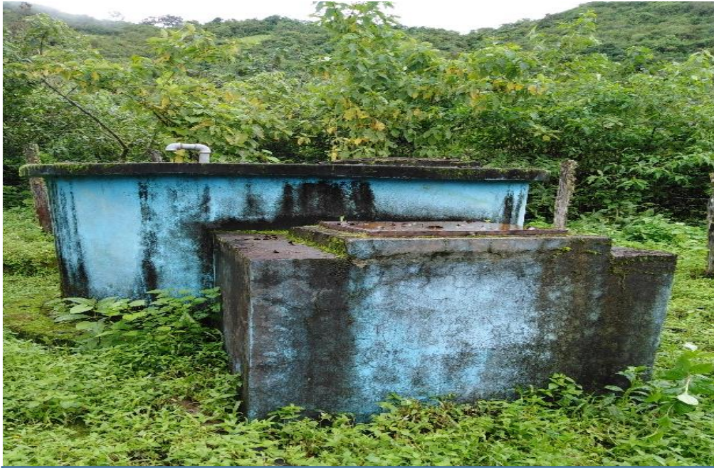
Figura 03. Reservorio del caserío Cangrejera. (Fuente propia)
