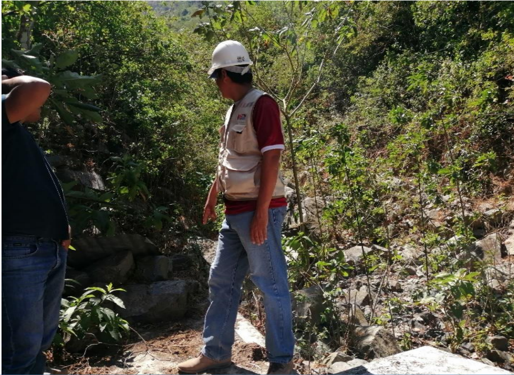
Foto N° 07. Área de captación del caserío Palacio.
