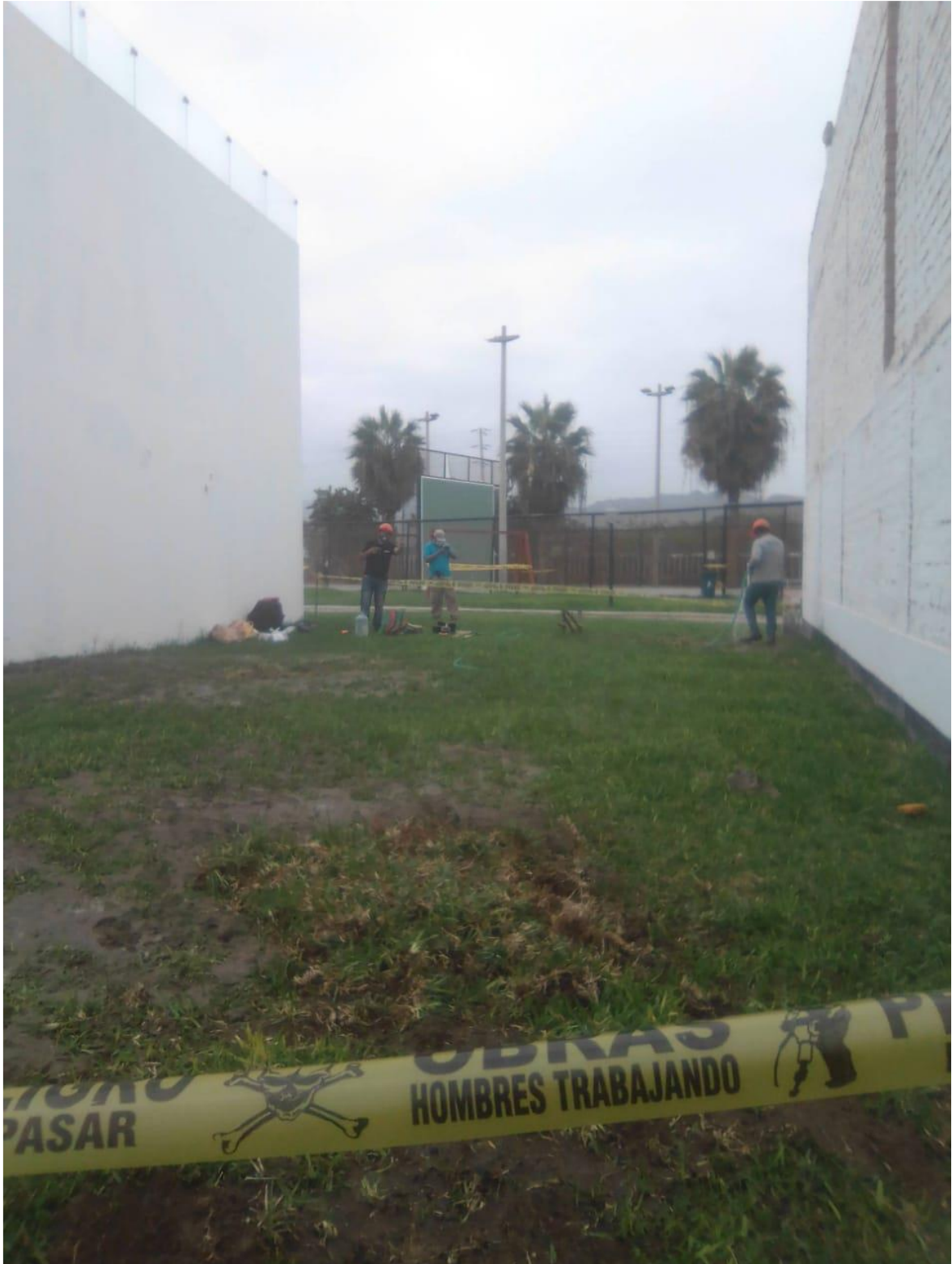
VISTA DE LA EJECUCIÓN DE CALICATA
