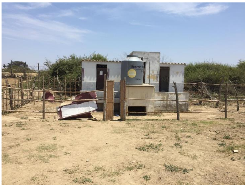
Figura 3. I.E.I.P. Luis Alberto Sánchez, SS.HH. de la institución, 2020.
