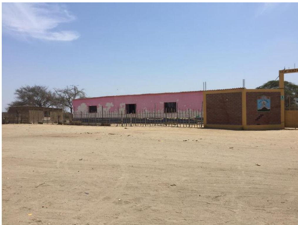
Figura 4. I.E.I.P. Luis Alberto Sánchez, Cerco perimétrico actual, 2020.
