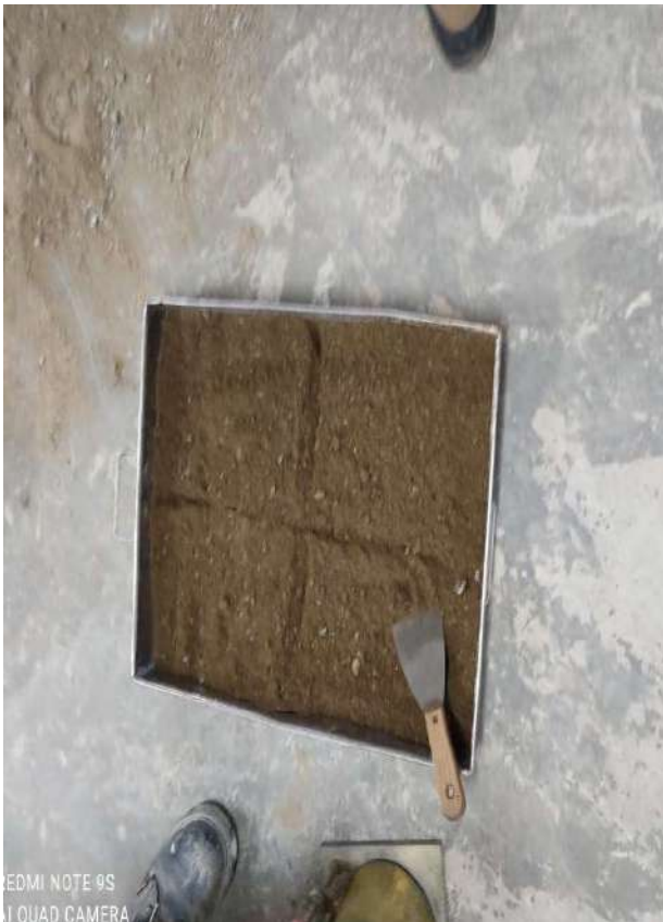
Cuarteo de la muestra de suelo, para proceder al ensayo PROCTOR.
