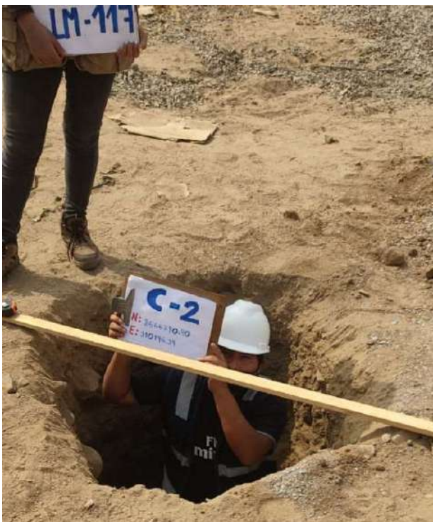
CALICATA N° 2 Coordenadas UTM: N: 8666790.40 E: 310196.39
