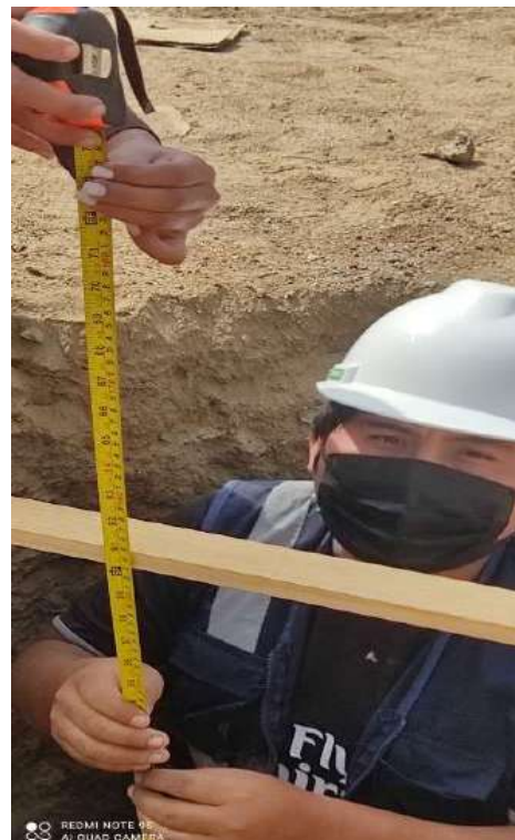
CALICATA N° 2 Carretera LM – 117 (Progresiva 11+000 km a 12+000 km)
