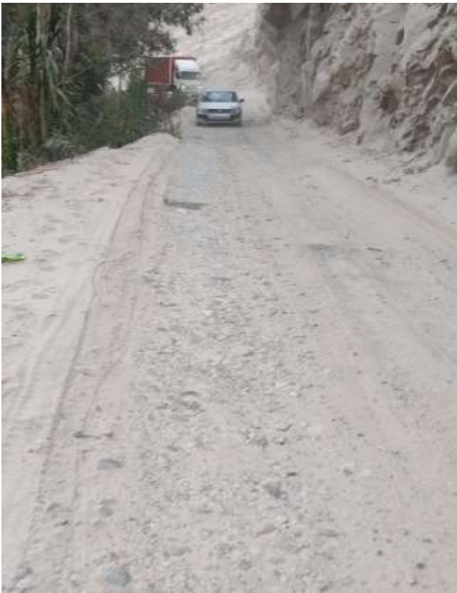
Carretera LM-117 (Progresiva 10+000 km a 11+000 km)
