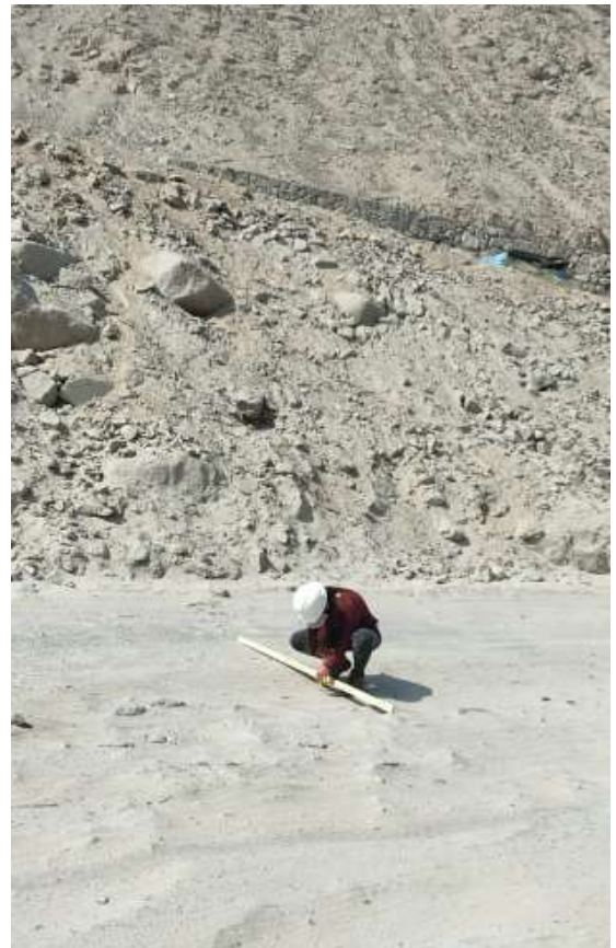
Inspección PCI Carretera LM-117 (Progresiva 11+000 km a 12+000 km)
