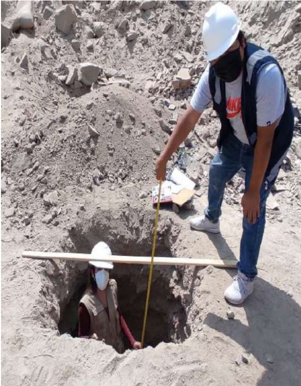
CALICATA N° 1 Carretera LM – 117 (Progresiva 10+000 km a 11+000 km)
