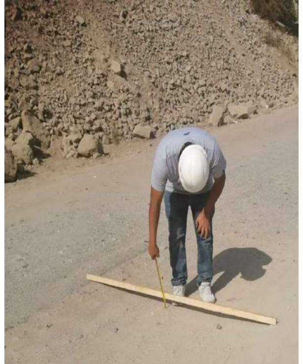
Inspección PCI Carretera LM-117 (Progresiva 10+000 km a 11+000 km)
