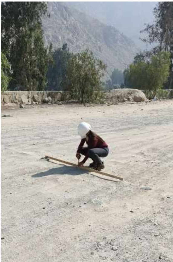
Inspección PCI Carretera LM-117 (Progresiva 11+000 km a 12+000 km)
