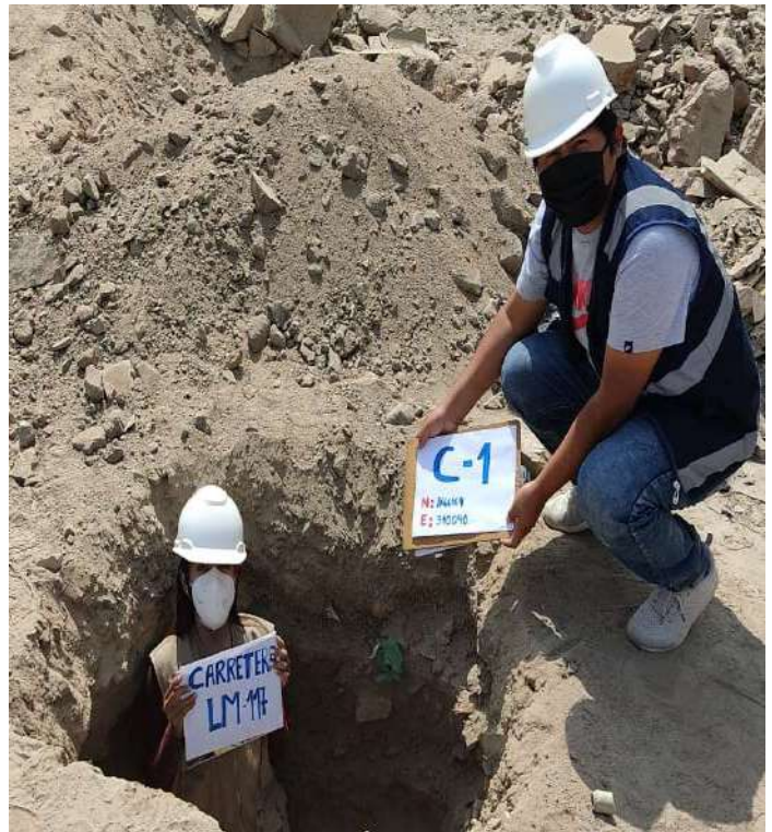
CALICATA N° 1 Coordenadas UTM: N: 8666169 E: 310090
