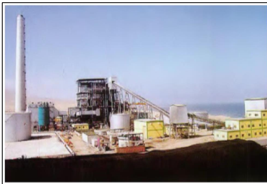
Figura 7. Vista General de la Central Termoeléctrica ILO21
