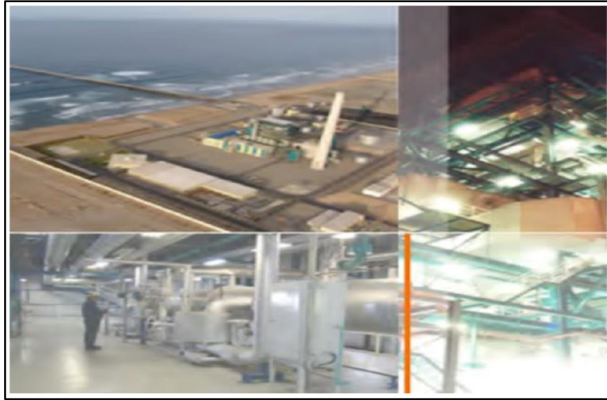
Figura 8. Vista Interior de las Instalaciones de Central Termoeléctrica ILO2
