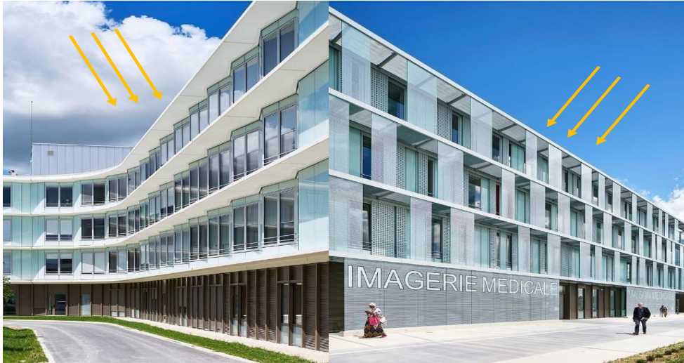
Gráfico 30. Fachadas con aislamiento solar y/o Parasol
